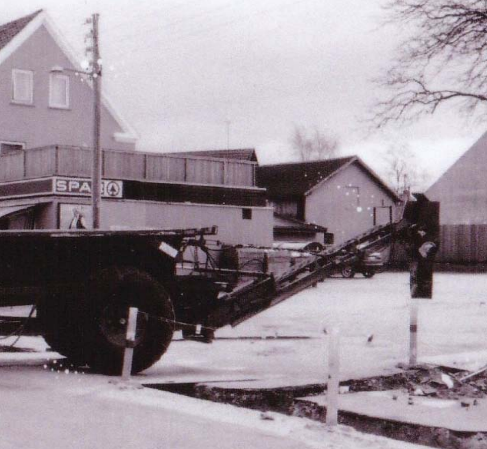
Fjernvarmens rør graves ned. Tisvildeleje 1997. Foto: Paul-Erik Nielsen, FAA.
