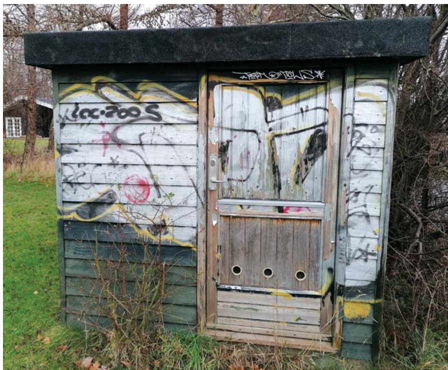
Den gamle, udtjente pumpestation ved Godhavn – kontrast til det nye akkumuleringsanlæg samme sted. Foto: Chr. Friis.
